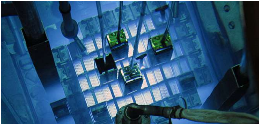
Figura 2. Núcleo del RA-3 con los EECC y las barras de control
